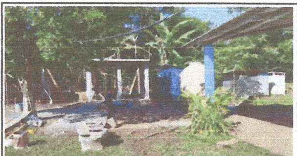
Foto 6: vista de la base del deposito para agua, losa de patio y modulo de baños sanitarios
