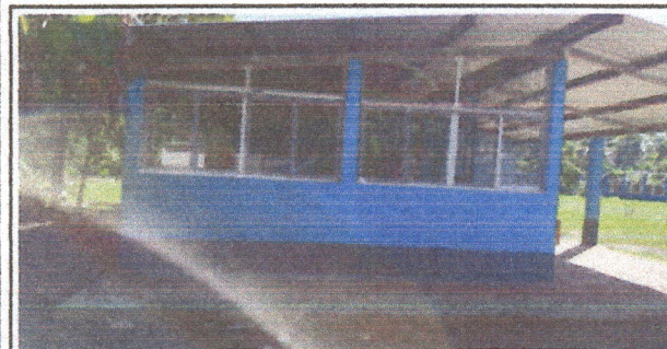
Foto 5: vista del modulo intervenido con ventanas pvc, laminas troqueladas, estructura de metal, pasillo de concreto, pintura de paredes
