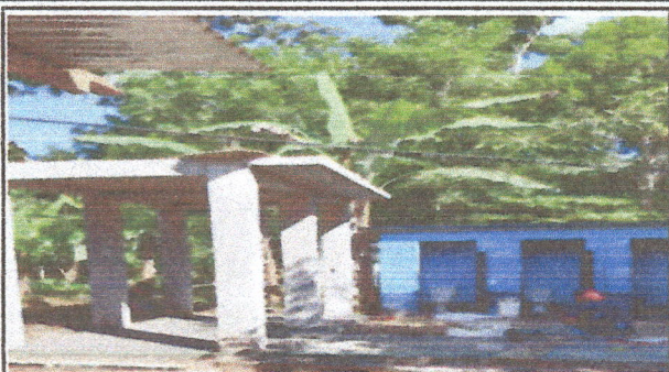
Foto 2: vista del modulo de baños y la base del deposito de agua
