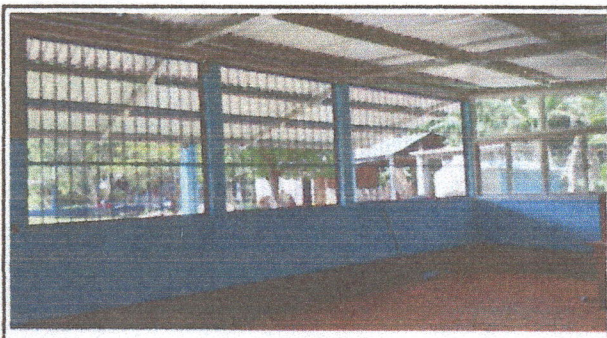
Foto 4: vista de las paredes pintadas y balcones instalados
